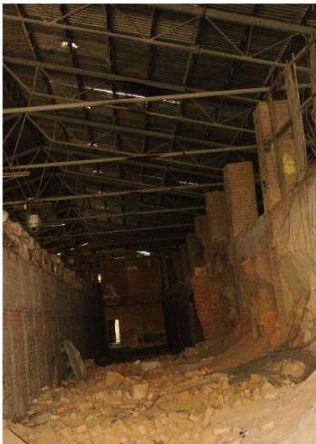
Fornace Faccioli (interno)
